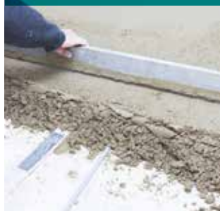
• Solera de concreto •
