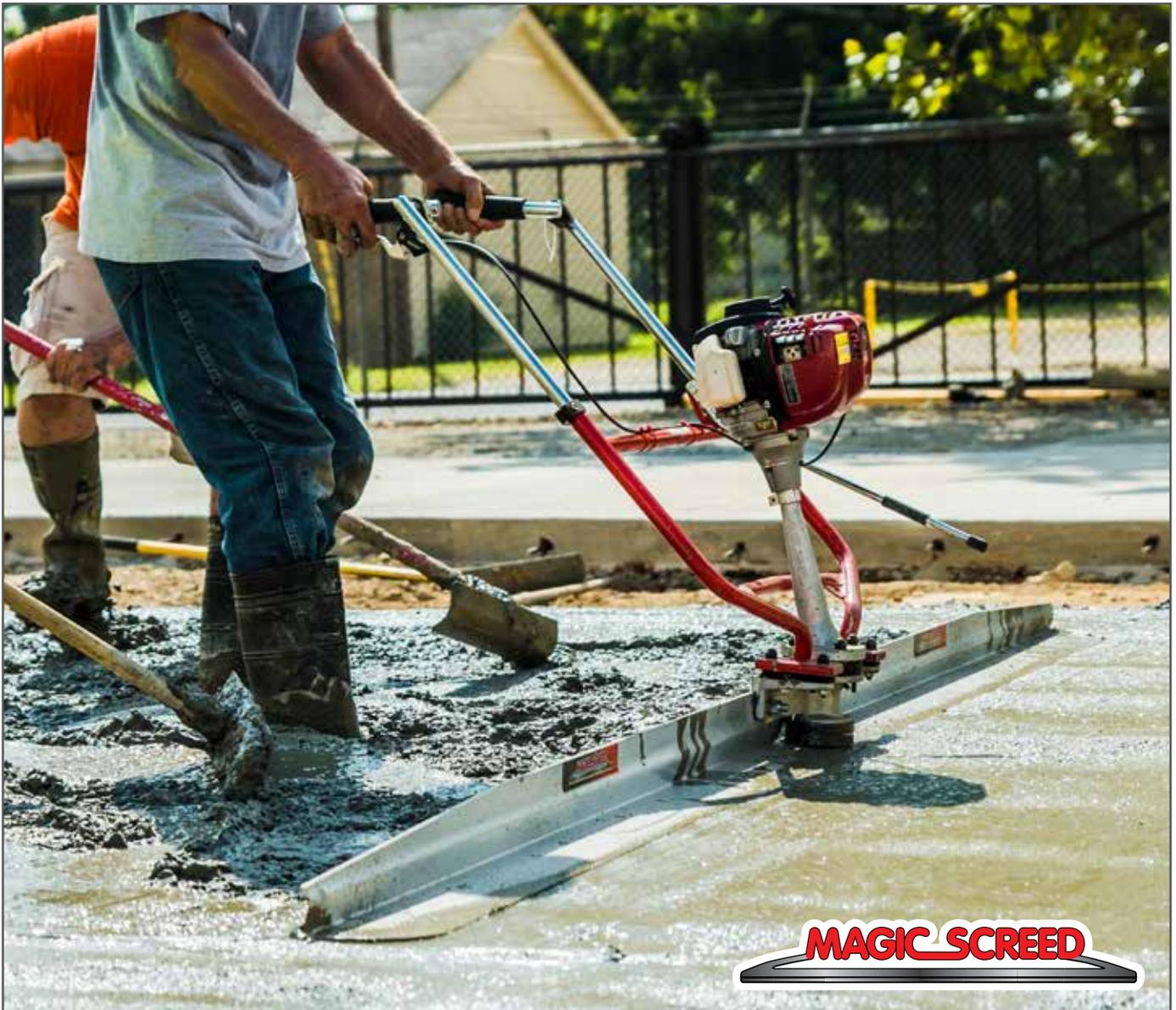
Magic Screed es una hoja talladora ligera con ingeniería de precisión para que un solo operador pueda tallar el concreto. Rápida y fácil de usar, esta regla de alta frecuencia proporciona una distribución uniforme en toda la longitud de la hoja, mejorando la integridad estructural del concreto a través de la consolidación.
